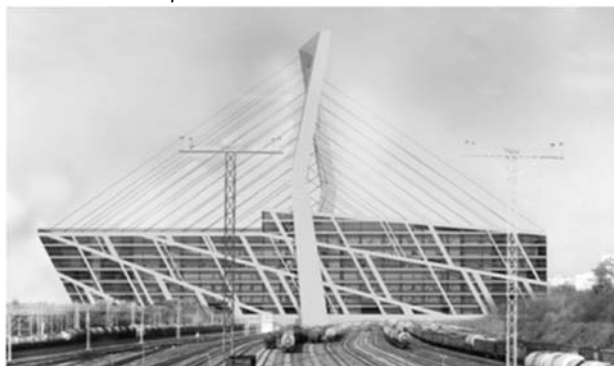
Рис.5 Вантовое здание -мост с торговым центром над Ярославской железной дорогой в районе станции Лось г.Москва. Арх. Демьяненко А.
